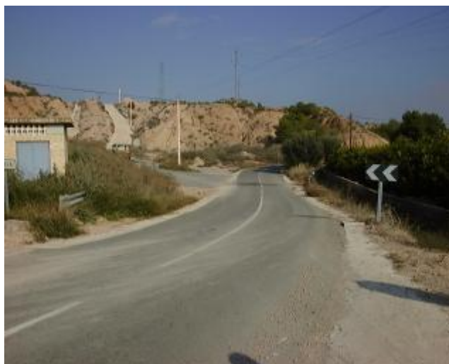
Fotografía 7: Se muestra el badén de la carretera hacia Fuente Librilla, la ocupación de la rambla de Las Oliveras por huertos y una mota, disimulada por la vegetación de la izquierda, dificulta la salida de la rambla desviando el flujo hacia un camino rural que sale justo al lado de la señal de dirección.
