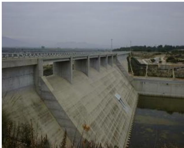
Fotografía 3: Se muestran las características generales de obra de la presa de gravedad del Romeral o José Bautista y los aliviaderos de coronación.
